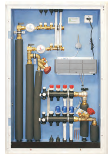
Päättävä pystymallinen keskus
