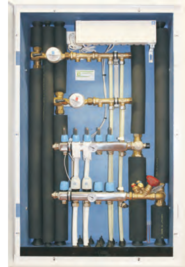
Läpimenevä pystymallinen keskus
